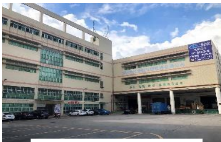
温度設定を持つ3階建倉庫
